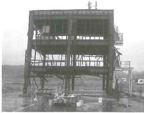
女性職員が最期まで住民に避難を呼びかけ続けた南三陸町防災センター。広い更地に立つむき出しの鉄骨が何とも痛々しい。
