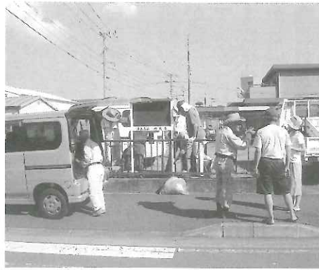
設置作業のようす (7月20日 岸田孝義様駐車場前)
